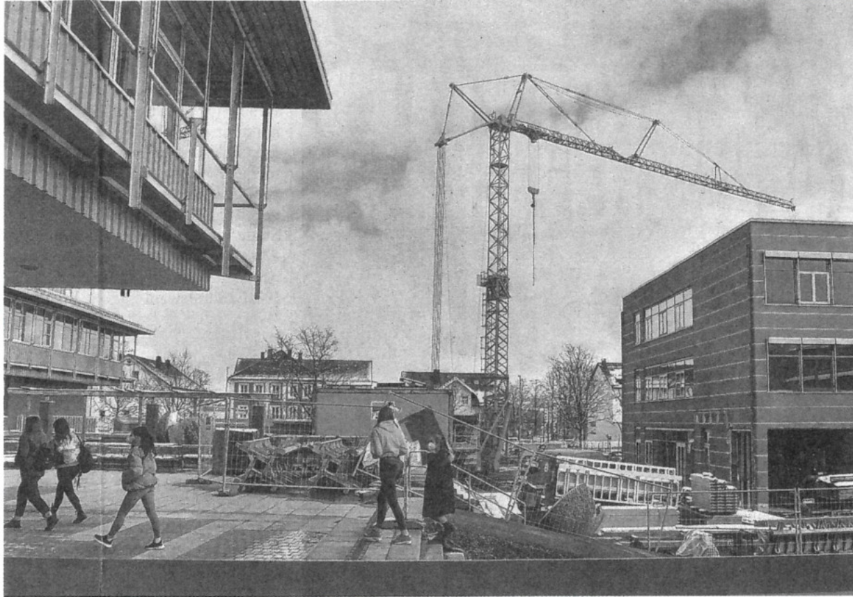
Zur Schule unter erschwerten Bedingungen: Bauarbeiten prägen zurzeit das Bild auf dem Campus in Kempten. Erweiterung und Sanierung werden das Berufsschulzentrum noch Jahre beschäftigen. Foto: Matthias Becker
