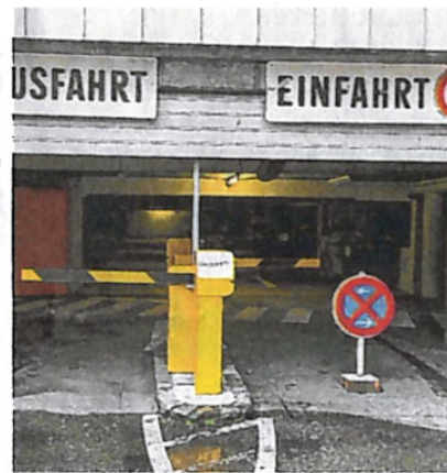
Die Tiefgarage ist gesperrt, da baufällig.
